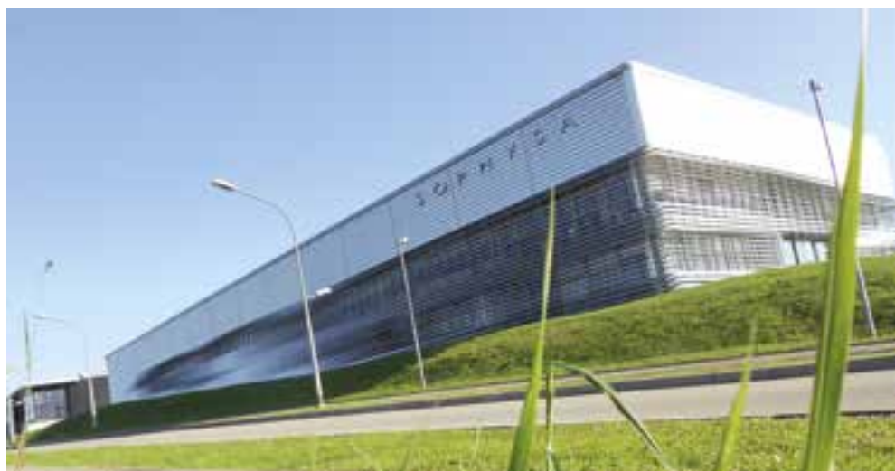
Sophysa Production Unit, Besançon (FR). Arquitecto: METRA & Associés. Fotografía: © Julien Cescon
